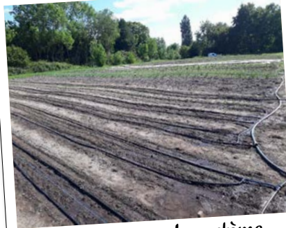
Installation du système goutte à goutte
