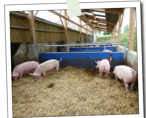
Le bâtiment d'engraissement
