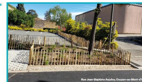
Arbre.s de pluie avec tranchée d'infiltration
