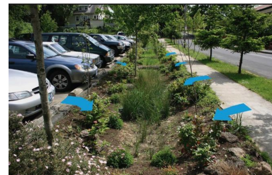
Arbre.s de pluie avec tranchée d'infiltration
