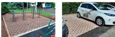
Chantier terminé © Grand Lyon
